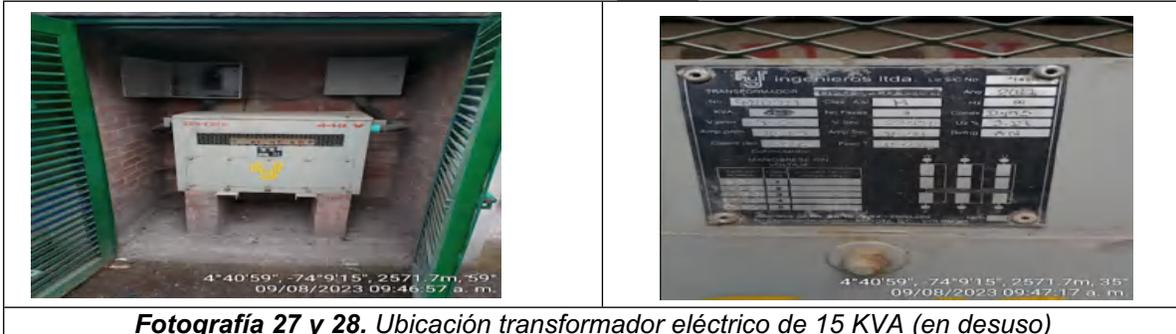
**Fotografía 27 y 28. Ubicación transformador eléctrico de 15 KVA (en desuso)**
