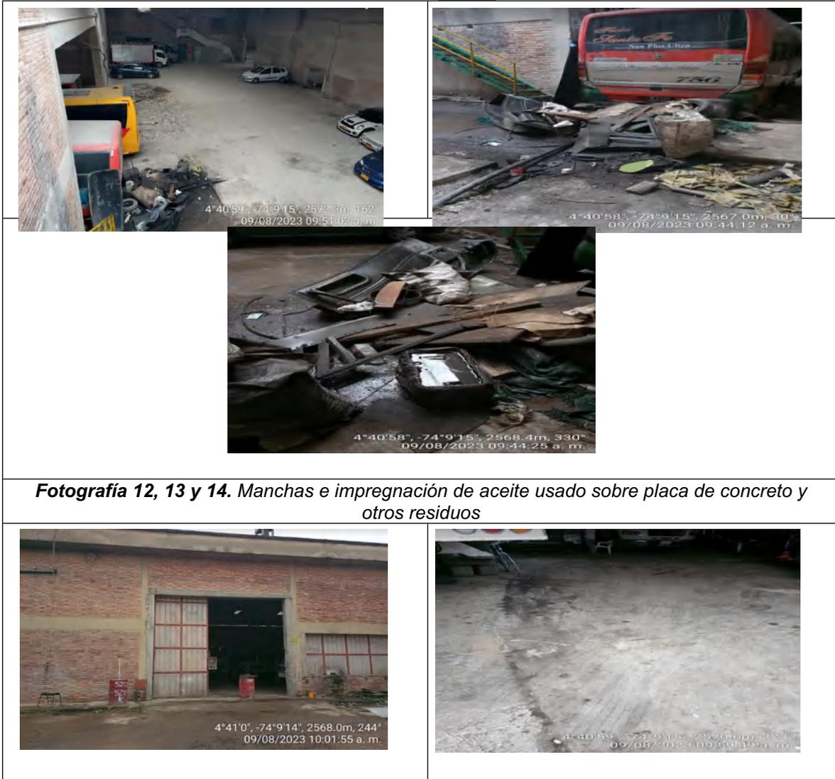
*Fotografía 12, 13 y 14. Manchas e impregnación de aceite usado sobre placa de concreto y otros residuos*
