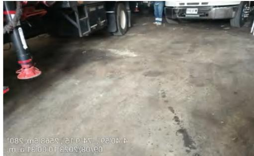
**Fotografía 15, 16 y 17. Bodega estacionamiento de grúas – algunas manchas sobre placa de concreto**
